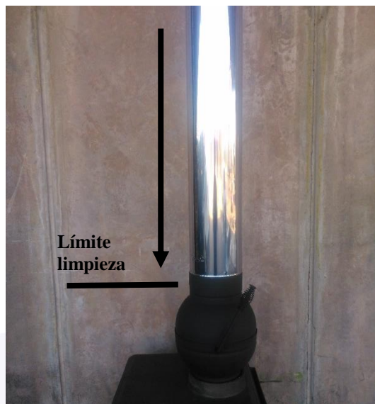
Figura 2. Límite hasta donde debe llegar el chascón o disco de limpieza del caño.
